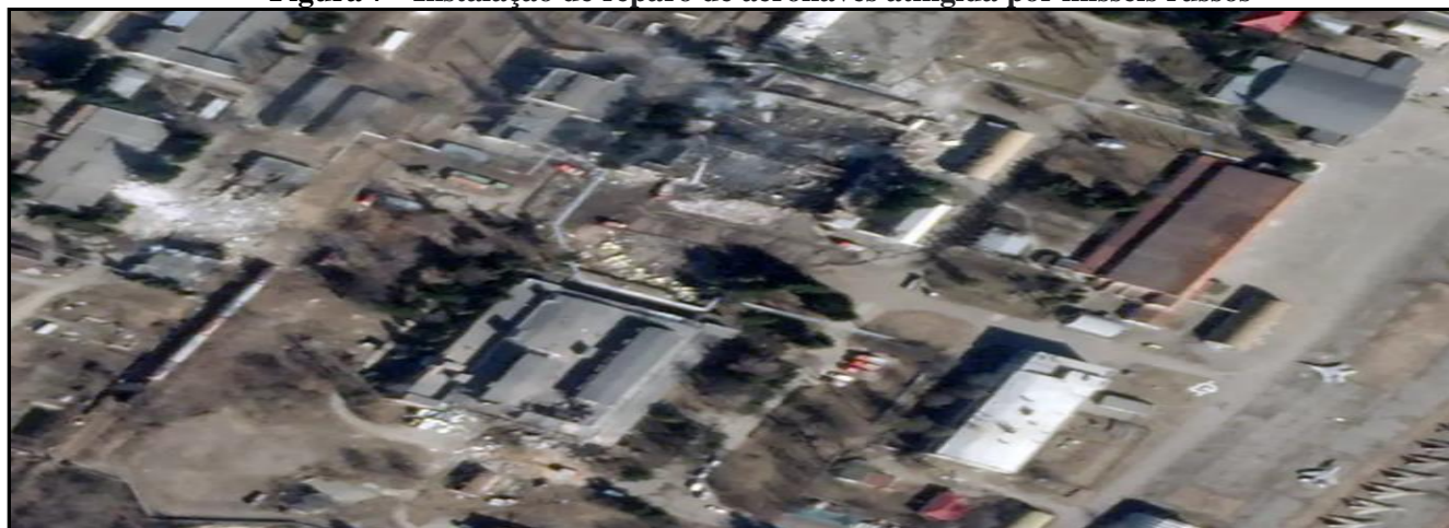
Figura 7 - Instalação de reparo de aeronaves atingida por mísseis russos
